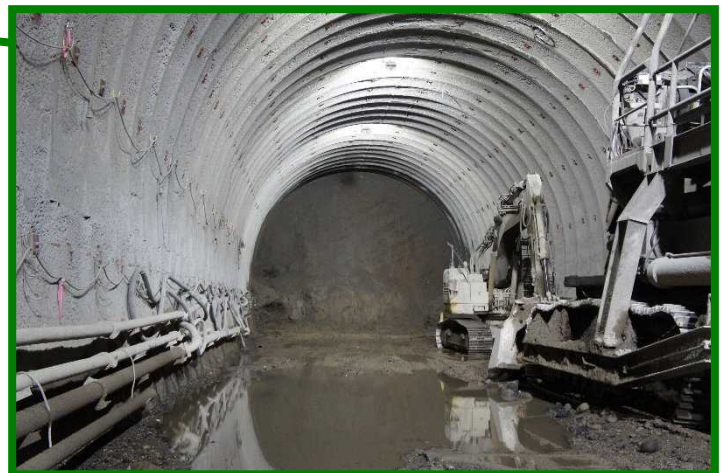
渡島トンネル（北海道 北斗市）
