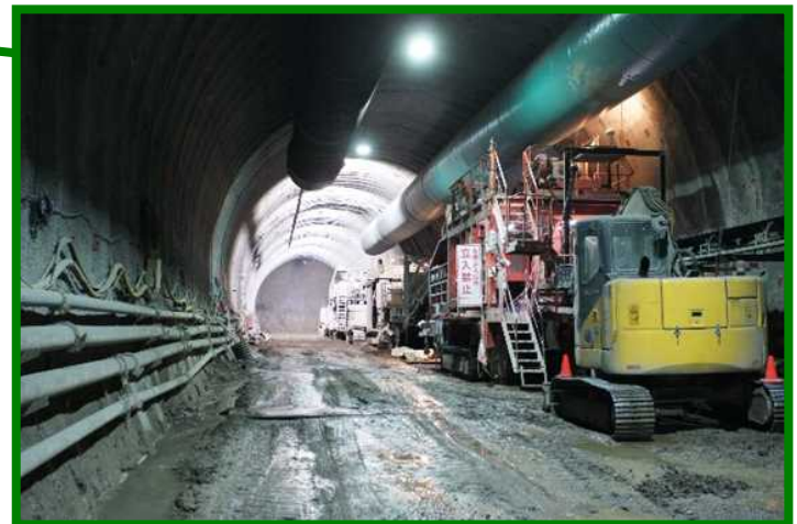
渡島トンネル（北海道 北斗市）
