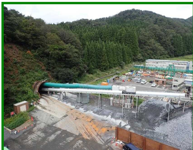
新北陸トンネル（福井県 敦賀市）
