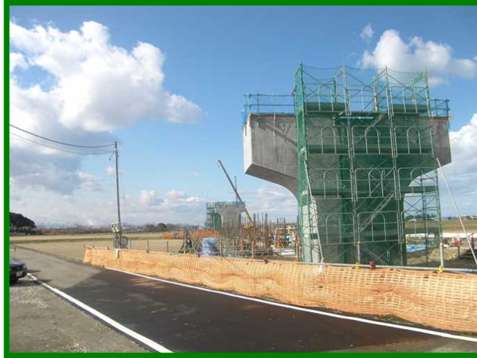
川北橋高架橋（石川県 川北町）
