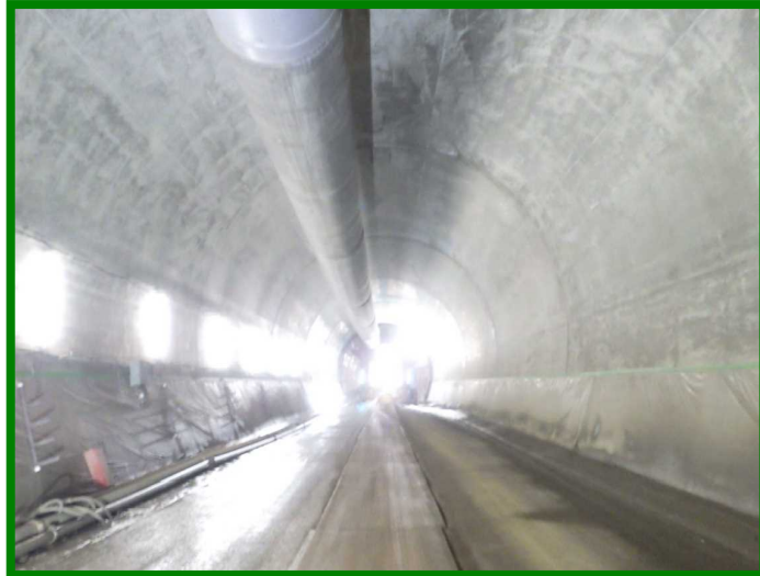
新北陸トンネル（福井県 敦賀市）
