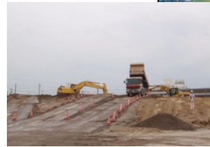
盛土の施工時
