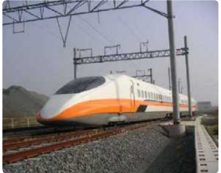
台湾高速鉄道建設（軌道・電気）への技術協力（台湾）
