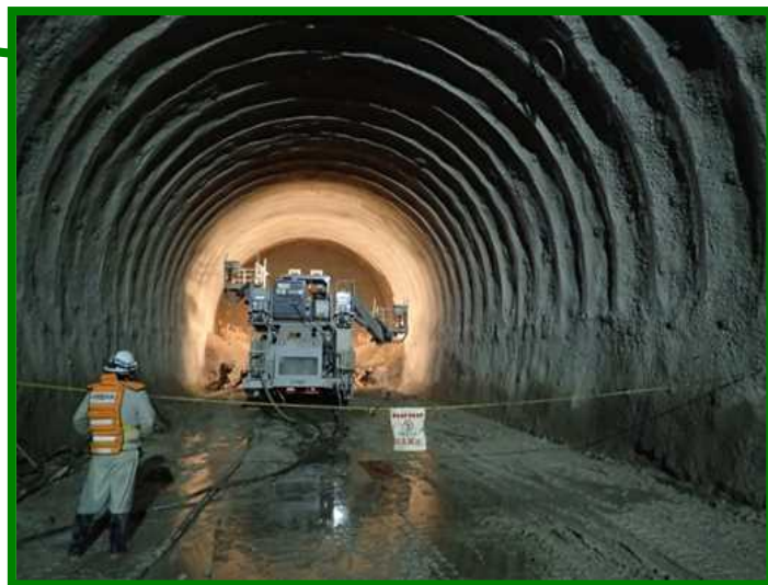
渡島トンネル（北海道 北斗市）
