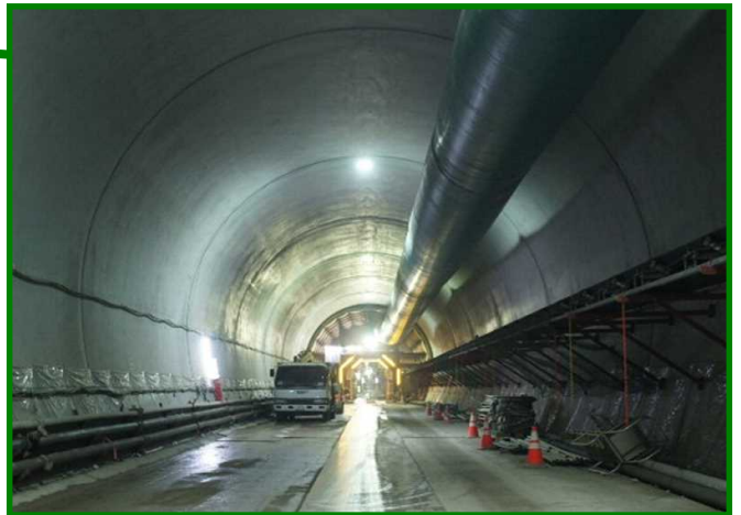
村山トンネル（北海道 北斗市）
