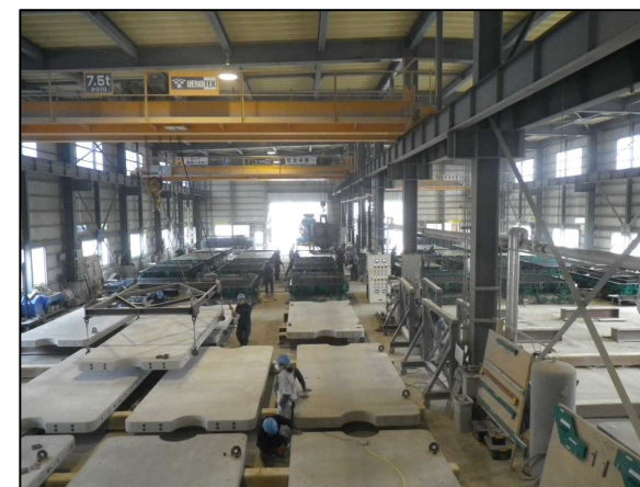
軌道スラブ製作状況
