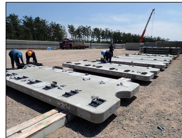
軌道スラブ製作状況
