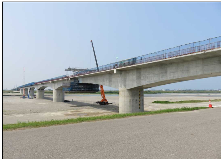
手取川橋りょう（石川県 川北町）
