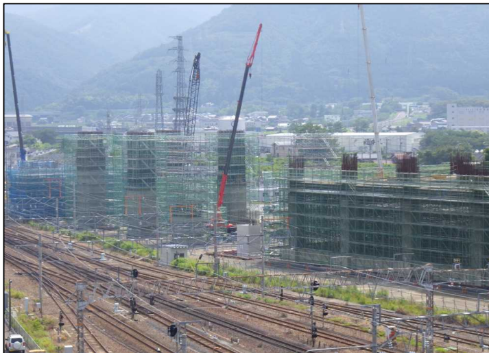
敦賀駅高架橋（福井県 敦賀市）
