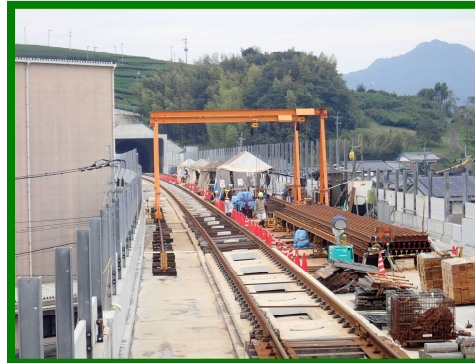
軌道工事状況
