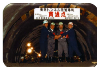
先進導坑の貫通
