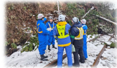
鉄道災害調査隊による被害状況の調査 （令和6年能登半島地震 のと鐵道）
