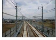
安全性<br>施工性<br>品質<br>出来形      | 電車線の挙動を把握し、集電性能向上による安全性、信頼性が向上することを確認できた。                                                                                       | 北海道新幹線(函・札)以降の整備新幹線を予定 | 電気  | 電車線 | 電車線細         | 架線勾配    | R7.5 | —    | —   |
