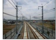
経済性<br>品質<br>出来形               | 鋼管柱および鋼管ビームの効率的かつ経済的な選定方法を確立した。<br>高強度部材を電車線柱へ適用し、耐震設計上問題ないことを確認した。                                                             | 北陸新幹線(金・敦)以降の整備新幹線     | 電気  | 電車線 | 耐震設計電車線      | 応答加速度   | R7.5 | 1件   | —   |
