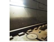
経済性<br>安全性<br>施工性<br>品質<br>環境 | トンネル用LED照明器具のを試作し、各種試験を行い実用性を確認した。<br>照明器具をLED化することで、ライフサイクルコスト、ライフサイクルアセスメントともに蛍光灯に比し低減されることを確認した。                             | 九州新幹線(武・長)以降の整備新幹線     | 電気  | 電力  | 照明           | トンネル照明  | R7.5 | —    | —   |
