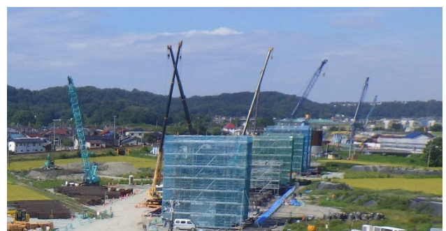
写真一 1 労務者・資機材集中投入の例 (石川県加賀市)
