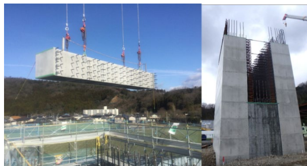
写真－8 ハーフプレキャスト橋脚架設状況
