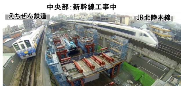
写真－５ 両側を営業線に挟まれた施工状況
