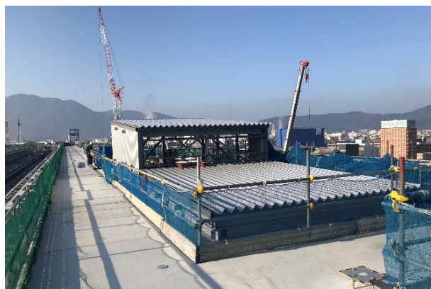
写真－14 高架橋開口部を閉塞する仮設屋根
