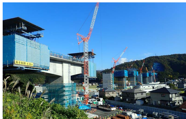
写真－9 超大型移動作業車による PC 桁架設状況
