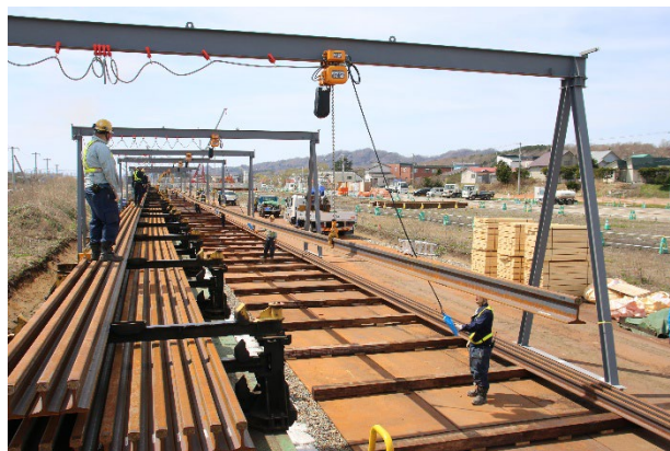
写真-5 150m レール取り卸し状況
