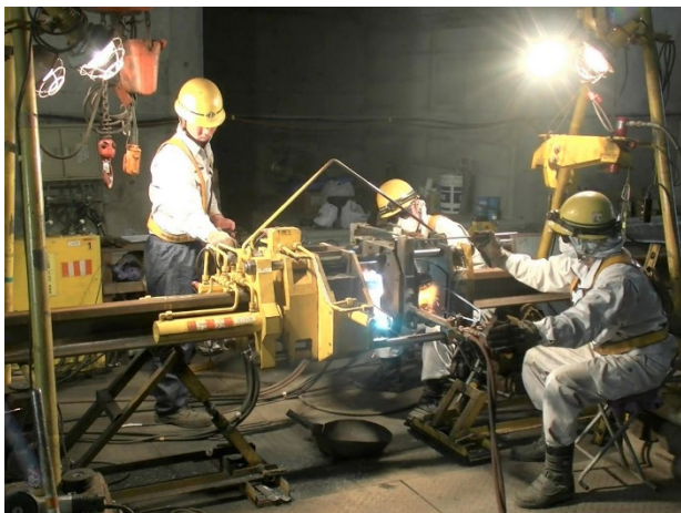
写真－３ ガス圧接作業状況
