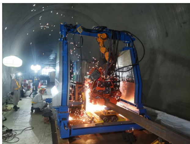
写真－6 フラッシュバット溶接作業状況
