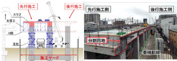
図-4 スラブの分割施工状況
