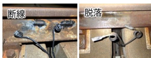
図－３ 送着ボンドの断線・脱落事象
