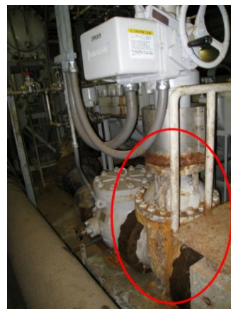
写真－2 設備劣化状況の一例(排水ポンプ)
