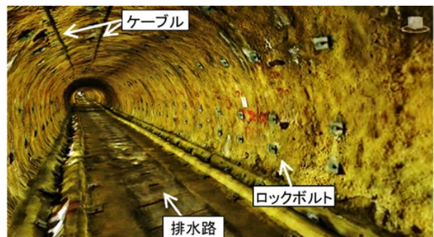
図-13 変状箇所の3次元画像化
