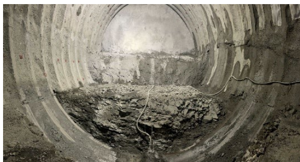
写真－２ 円形支保工施工状況
