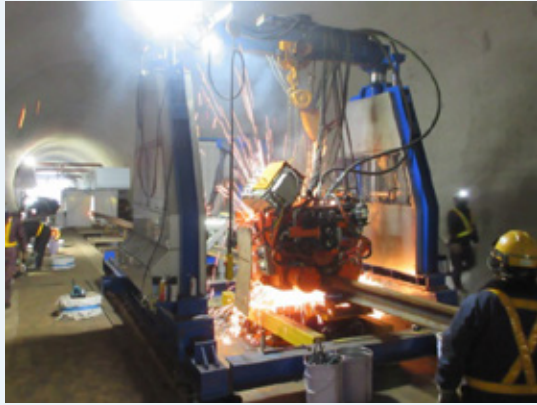
フラッシュバット溶接（左：テスト溶接状況、右：北海道新新幹線の現場溶接状況）
