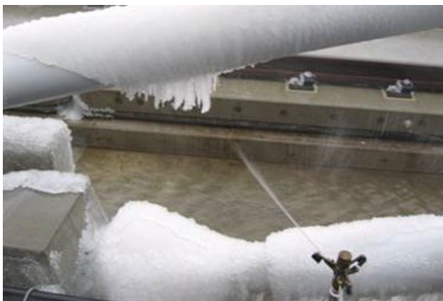
写真－６ 橋梁斜材の着氷発生
