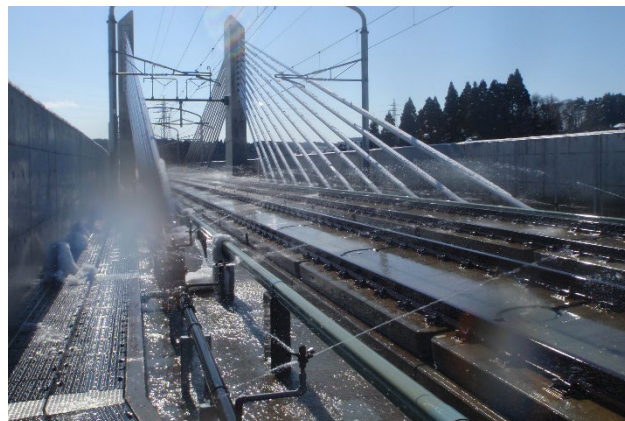
写真－８ 橋梁斜材の氷柱が解消
