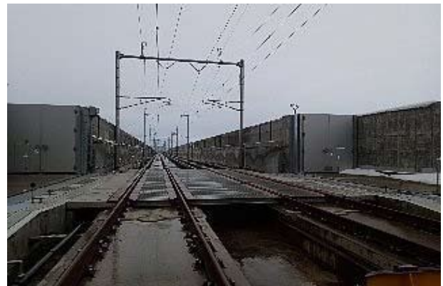
写真-4 軌陸車進入路部の残雪が解消
