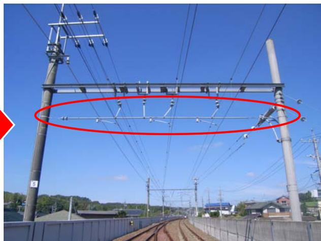
写真2 一括支持方式（切換時及び切換後）
