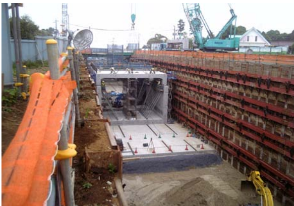
プレキャストブロック組立ての状況
