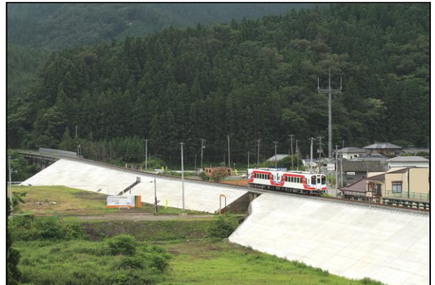
張コンクリート（海側）
