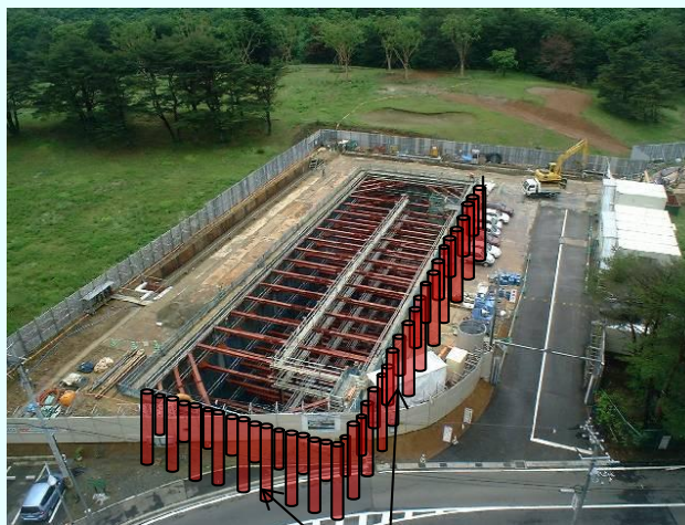
親杭+吹付コンクリート
