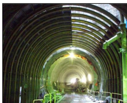
キーストプレート+吹付け
