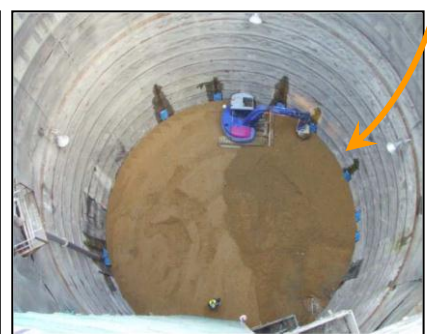
円形立坑の埋戻し
