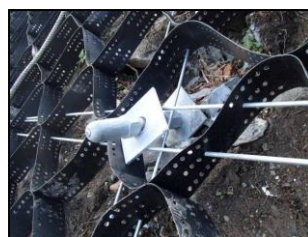
地山補強材頭部
