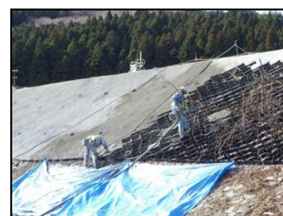
RRS 工法の施工状況
