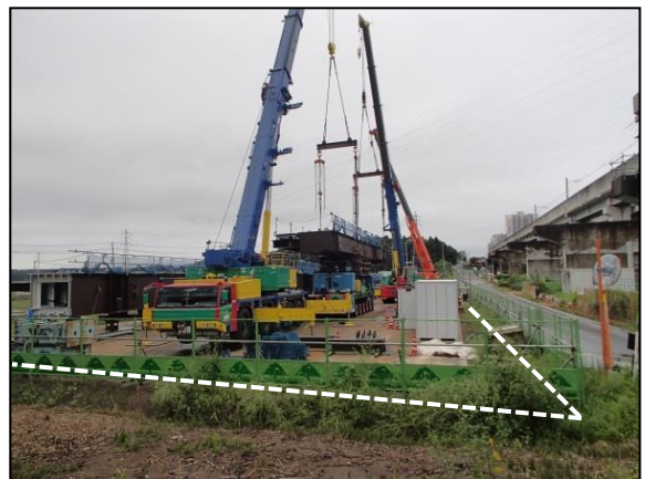
鋼桁地組ヤードの引継使用
