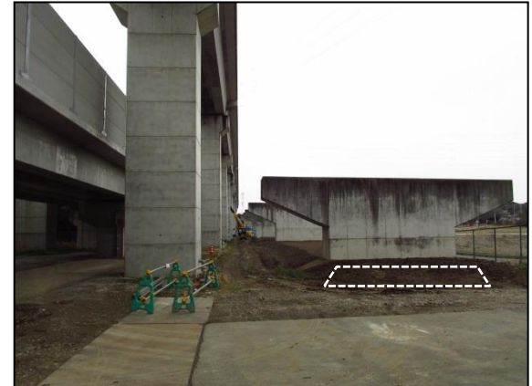
発生土の県都市軸道高架下敷均し
