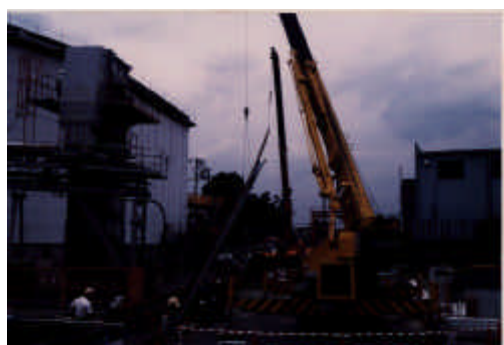
写真7-4-2 レール投入状況
