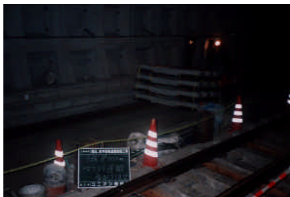
写真7-4-4 マクラギ運搬状況
