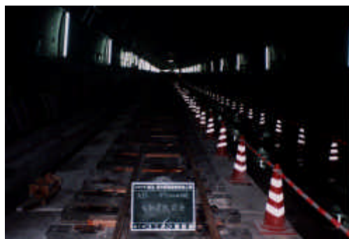
写真 7-4-1 土木通路線の確保
