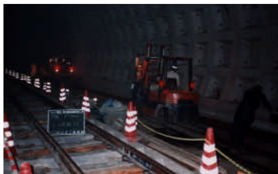
写真7-4-3 レール運搬状況
