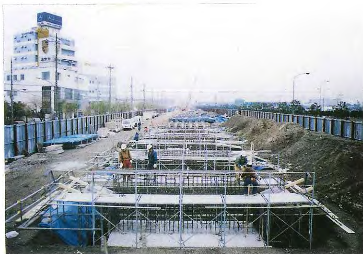
第2東雲B l 橋脚構築
