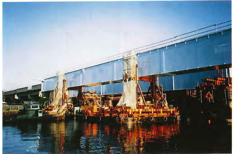
辰巳運河B 台船架設
