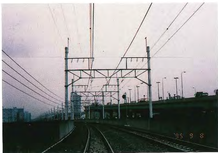
0km700m付近高架橋（起方側より望む）
