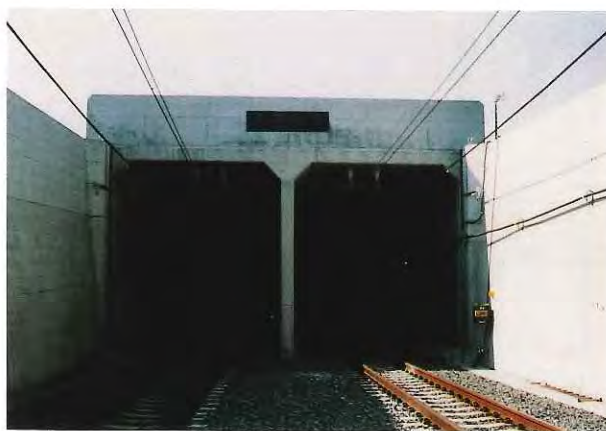
東臨隧道入口
