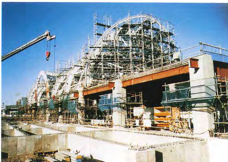
国際展示場駅 本屋鉄骨組立
