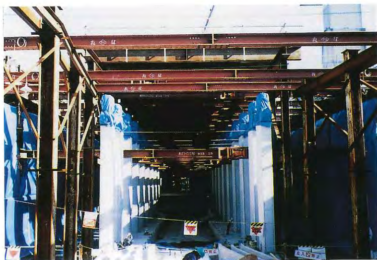
T 2 工区く体構築
