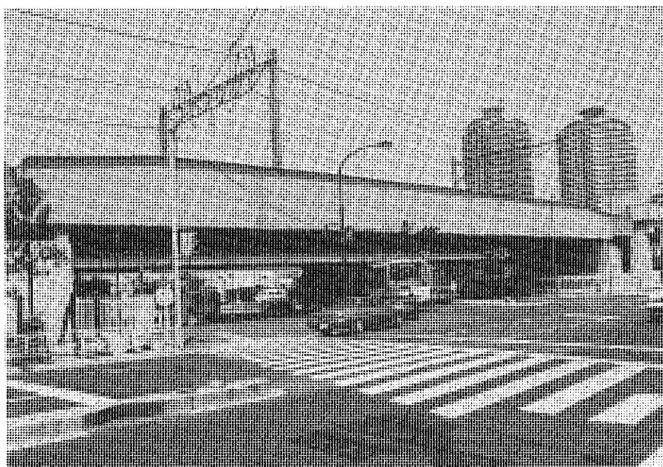
写真1-2-2 東雲架道橋（本線左側より望む）
