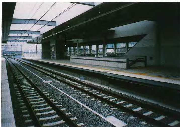
東雲駅（上り線ホームより下り線ホームを望む）
