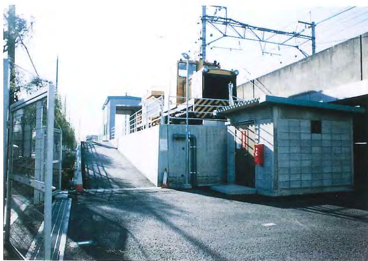
危険品庫 (後方はモーターカー庫)
