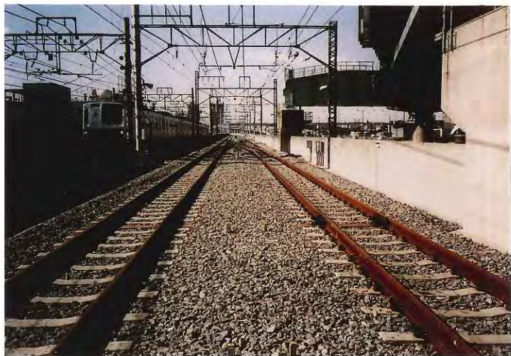
0km330m/付近シーサスポイント（始点側より望む）
