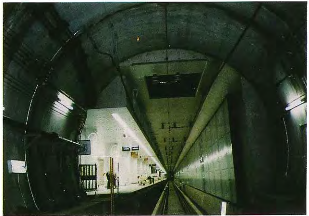
東京テレポート駅下り線（起点側を望む）
