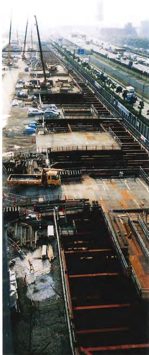
国際展示場駅 掘削
