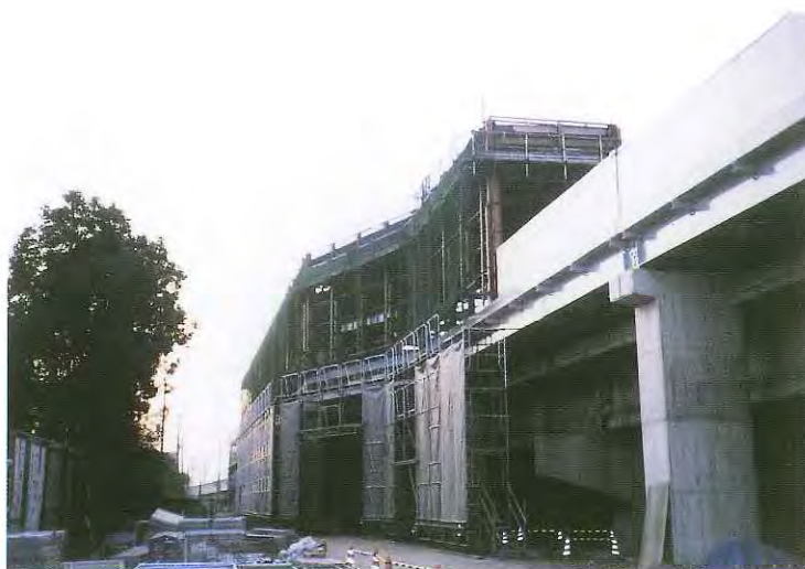
東雲駅 上家鉄骨組立
