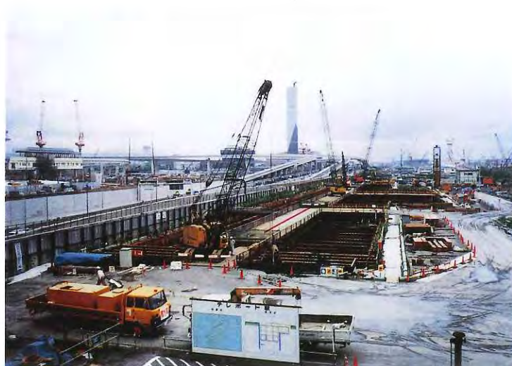
東京テレポート駅 掘削
