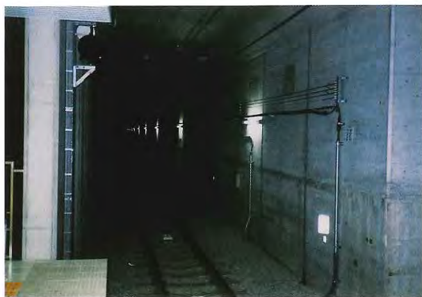
3k400m付近下り線 (国際展示場駅ホームより起点側を望む)
