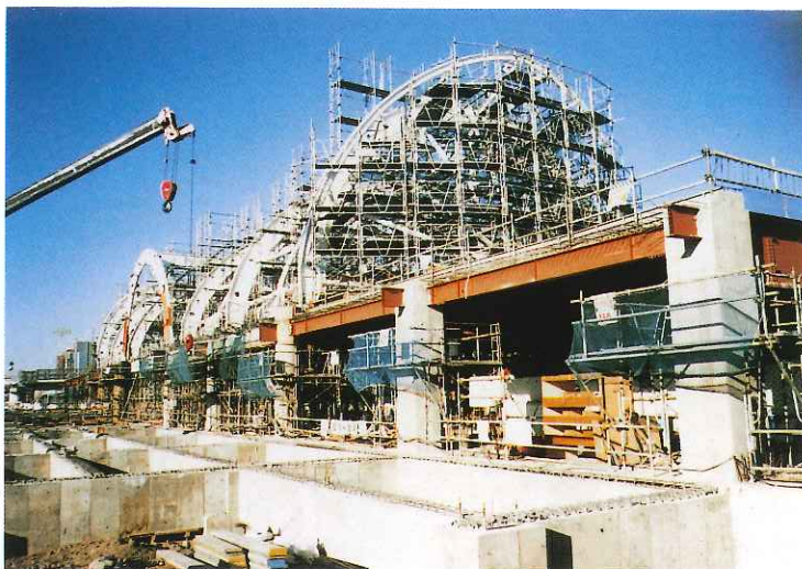
国際展示場駅 本屋鉄骨組立
