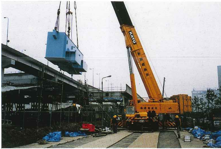
営団地下鉄B i トラッククレーン架設
