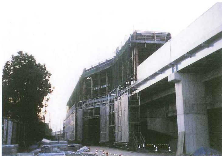
東雲駅 上家鉄骨組立
