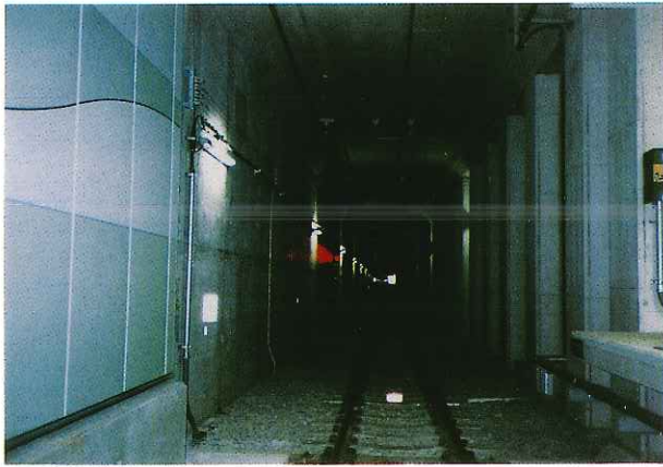
国際展示場 駅下り線（起点側を望む）
