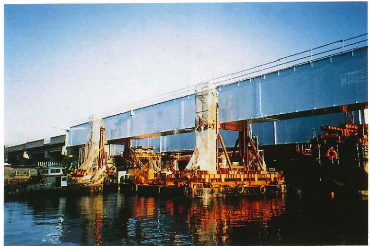
辰巳運河B 台船架設
