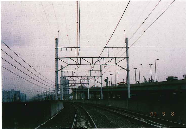
0km700m付近高架橋（起方側より望む）
