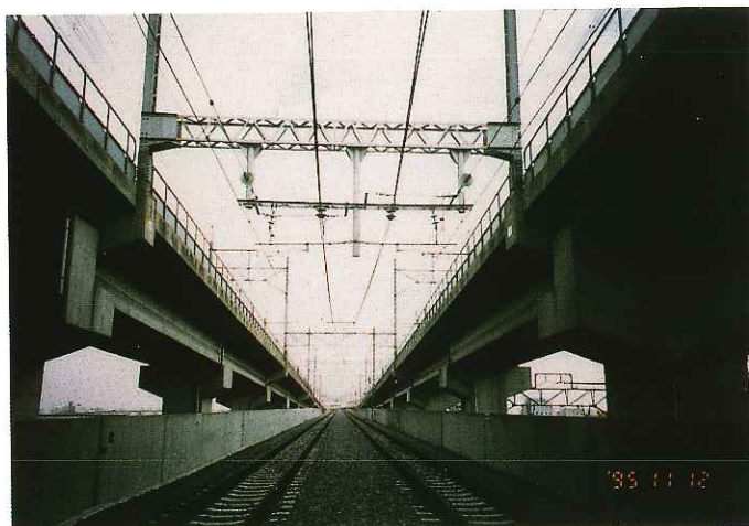
新木場駅起点方高架橋 (左右上はJ R京葉線)
