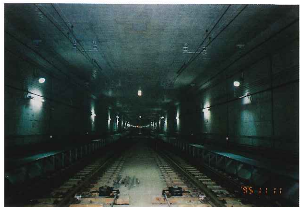
4k200m付近トンネル内シーサスポイント (終点側より望む)
