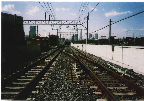
保守基地及び東臨隧道
