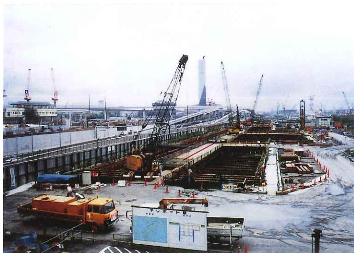
東京テレポート駅 掘削
