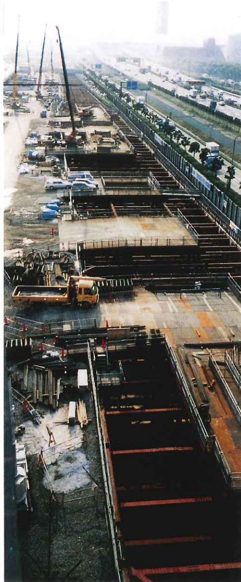
国際展示場駅 掘削
