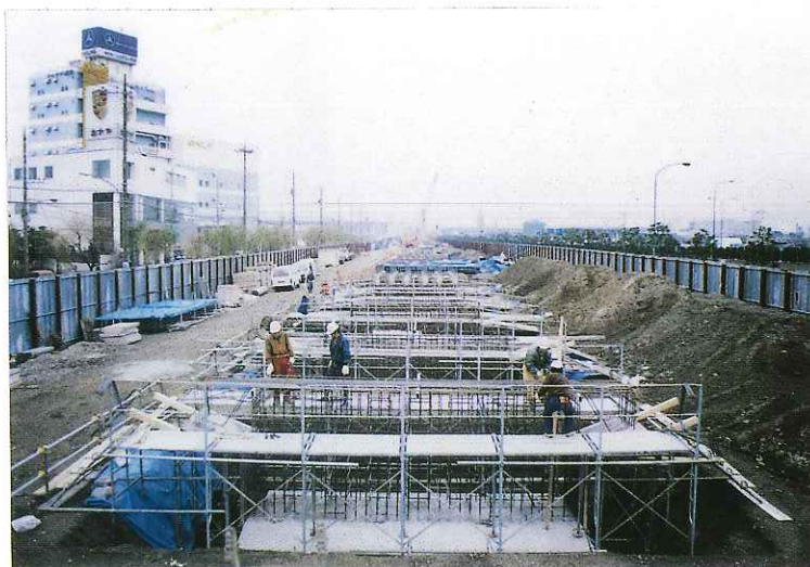
第2東雲BⅡ橋脚構築
