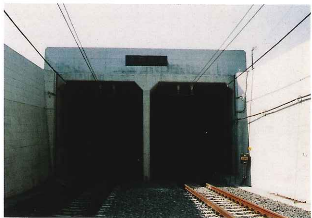
東臨隧道入口
