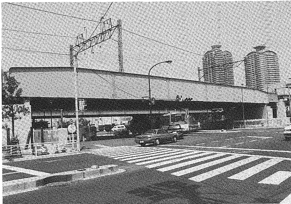
写真1-2-2 東雲架道橋（本線左側より望む）
