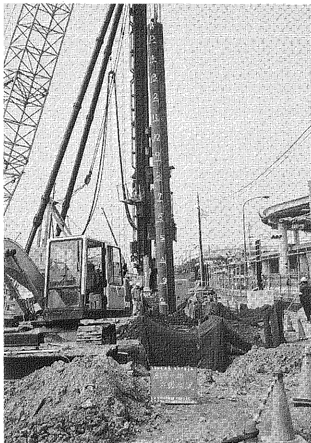
写真 3 - 6 - 13 鋼管矢板 V L 型打設状況
