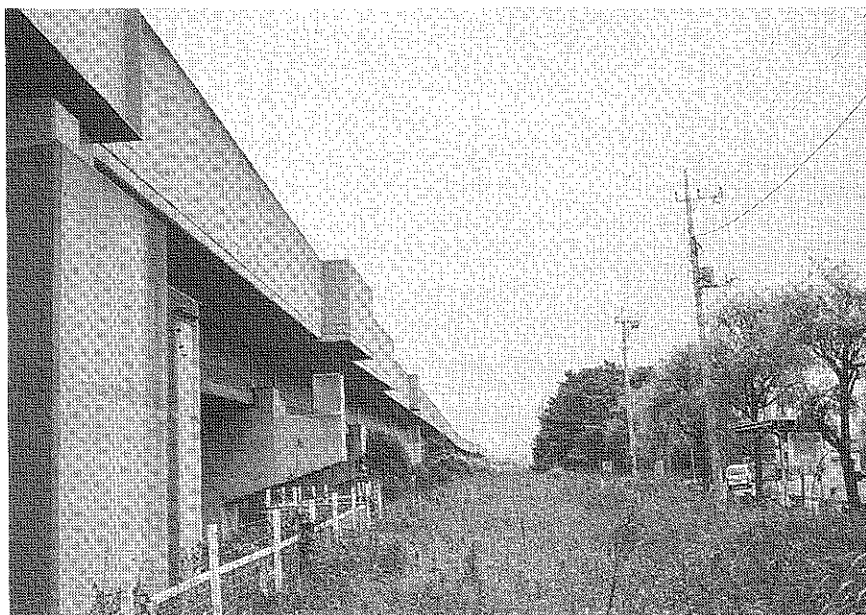
写真3-7-1-(b) 着手前 本屋部分
