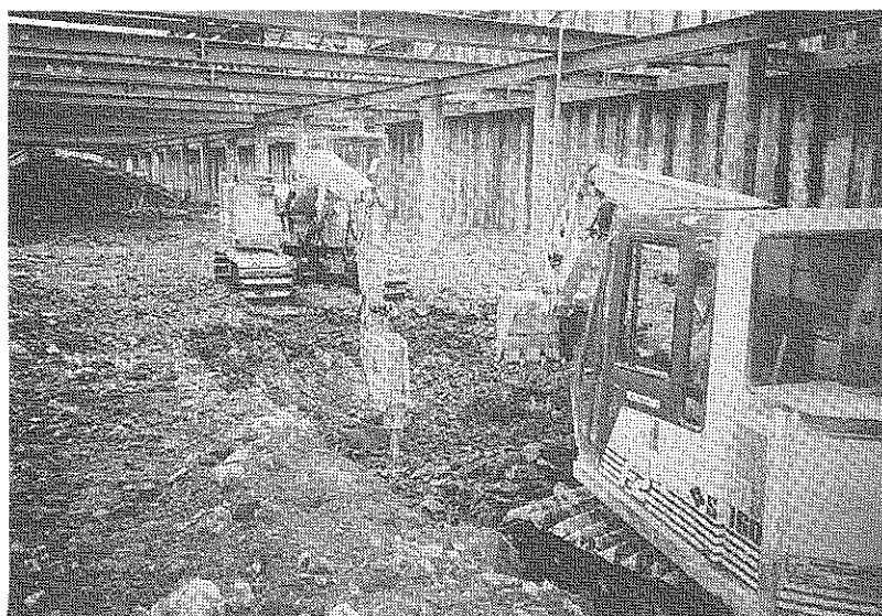
写真 3 - 8 - 3 国際展示場駅開さく（坑内）
