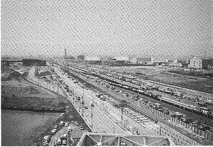
写真 3 - 4 - 3 U型よう壁部掘完了
