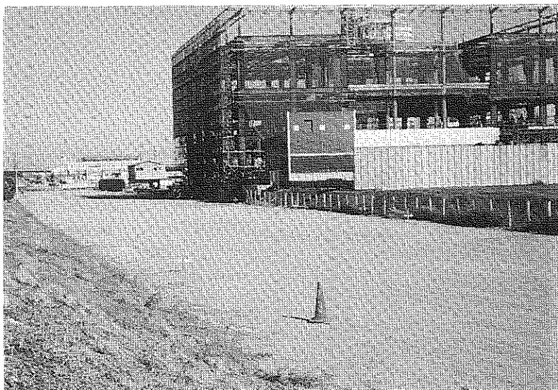
写真 3 - 6 - 40 しゅん功（終点方から起点方を望む）
