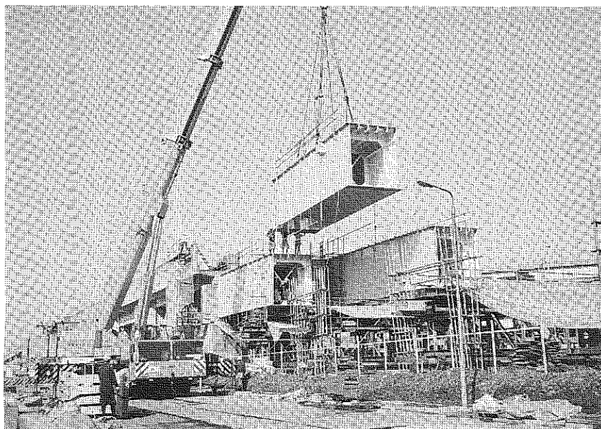
写真 3 - 5 - 3 トラッククレーンによる架設
