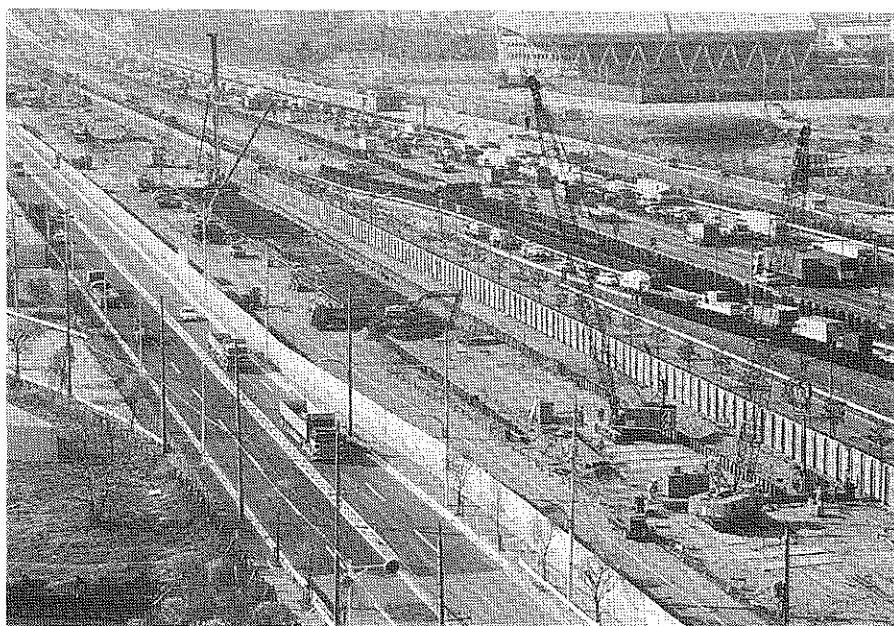
写真 3 - 4 - 1 U型よう壁部基礎杭打設
