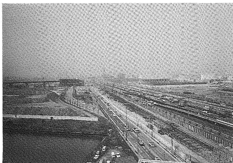
写真 3 - 6 - 2 有明 T - 1 掘削全景
