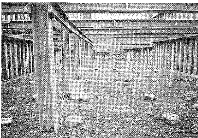
写真 3 - 6 - 1 有明 T - 1 掘削完了
