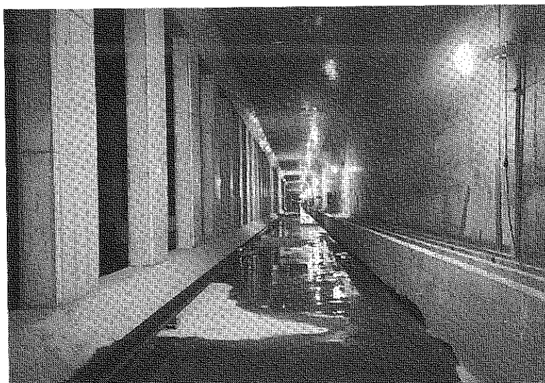
写真 3 - 6 - 41 しゅん功（ボックスカルバートトンネル）
