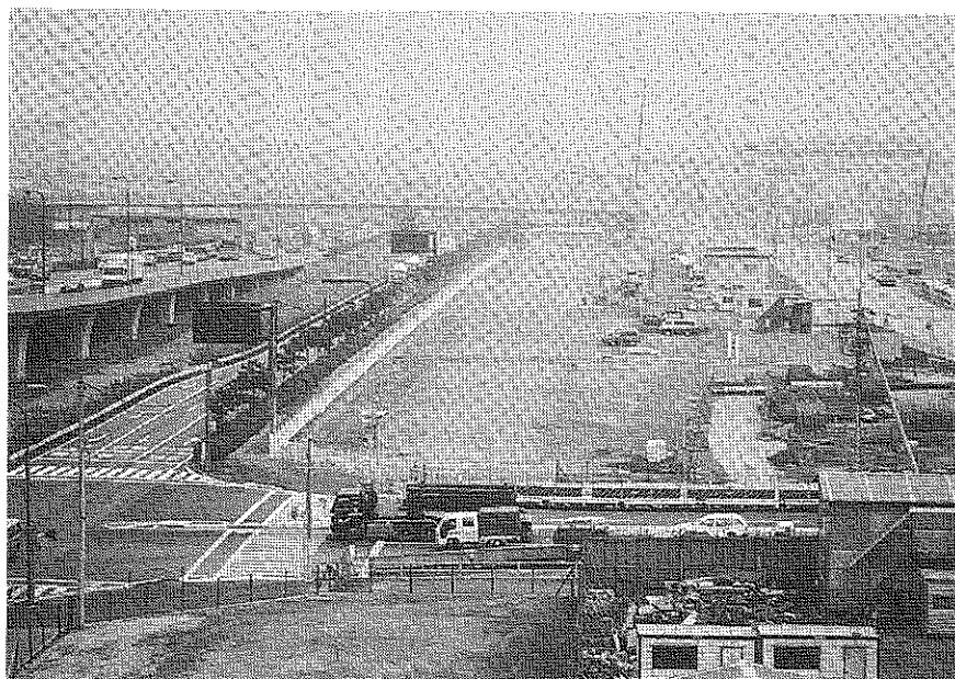
写真 3 - 6 - 25 しゅん功（起点方から終点方を望む）
