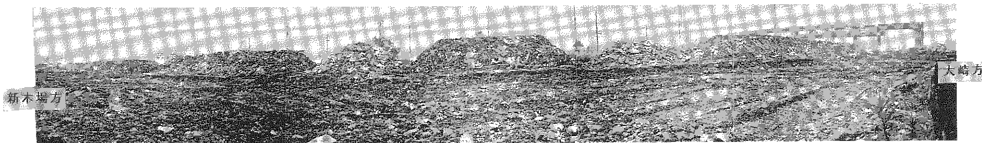
写真 3 - 6 - 6 発生廃棄物集積状況全景
