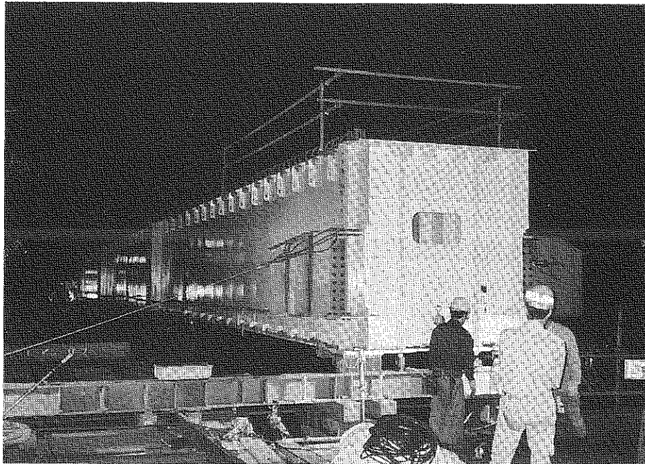
写真 3 - 5 - 2 下り線横取り架設中
