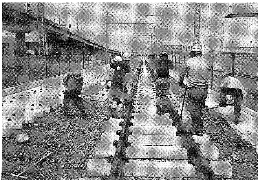
写真 4－3－3 レール縦送り・敷設
