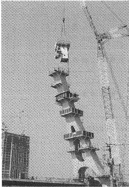
写真10-4-1 スカイウェイ橋主塔架設
