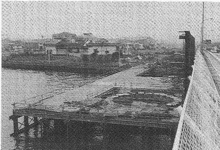
写真1-12 辰巳運河B終点方橋脚栈橋と鋼管井筒
