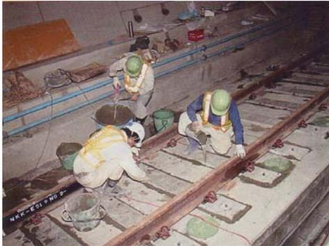
㉒ マクラギ箱抜き部無収縮モルタル充填
