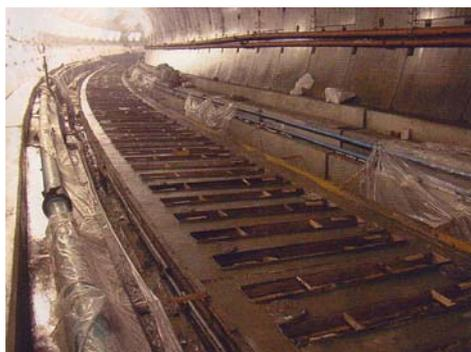
⑬ スラブコンクリート打設工(スラブ天端まで)
