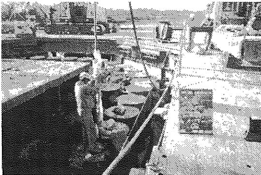
写真 4-5-5-44 継手止水工(ジャケット挿入)
