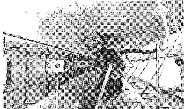
写真 4-5-5-22 コンクリート打設
