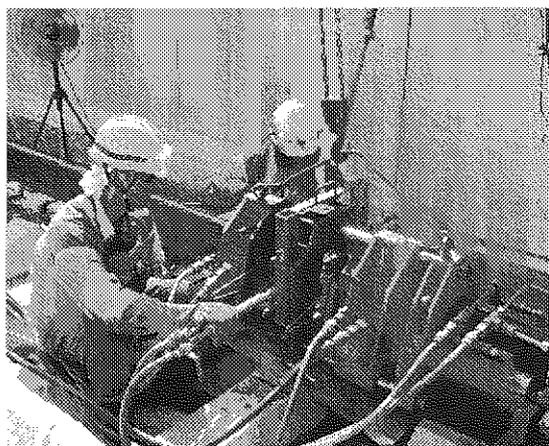
写真5-3-2-1 レール溶接（ガス圧接）
