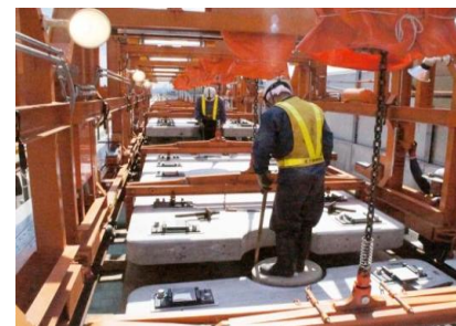
積み替えた軌道スラブを敷設
