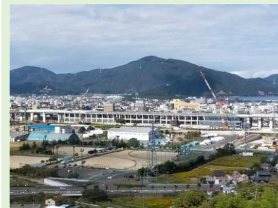
高架橋(土木)完成後
