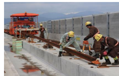
運搬したレールを敷設
