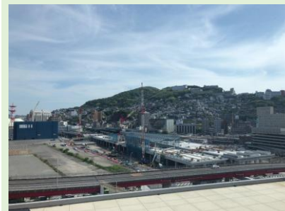
高架橋(土木)完成後
