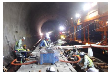
現場で直接モルタルを注入
