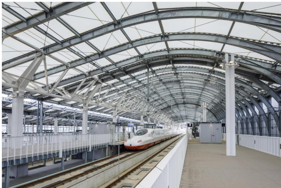
膜屋根を用いた開放的なホーム空間
