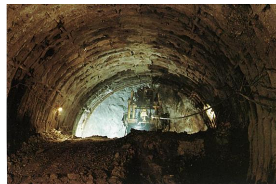
膨張性地山に対抗すべく、 NATMを国内で初めて試験導入。
