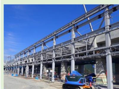
高架橋(土木)完成後
