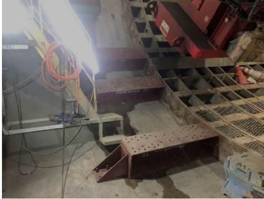
写真-2 内型枠後方に設置したH鋼材
