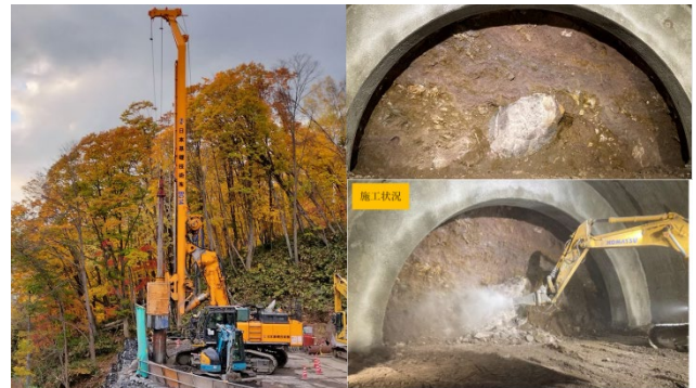
写真－3 (左) BG 工法による岩塊撤去 (右) NATM による岩塊撤去
