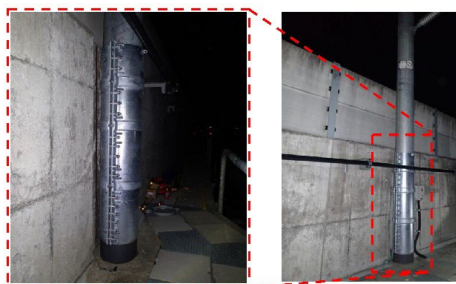
図-16 電柱振動抑制対策（過去の実績）
