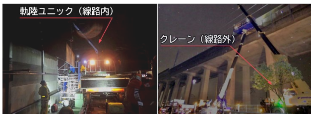
写真-2 クレーン施工状況
