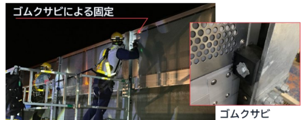
写真－5 吸遮音板の固定方法
