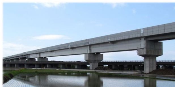
写真－1 A 橋（3径間連続合成桁）
