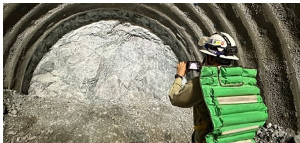
図-4 StarLinkを活用したトンネル通信エリアの構築
