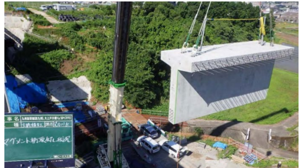
図-7 プレキャストによる橋梁工事
