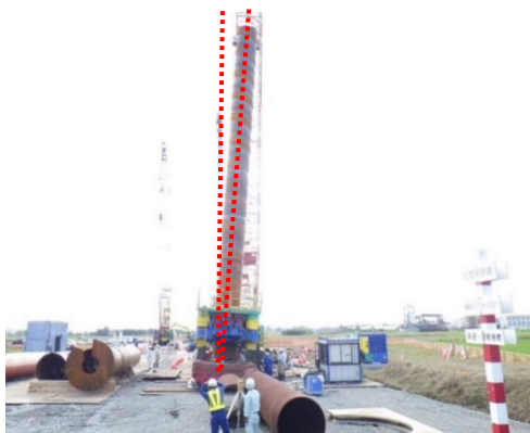
斜杭基礎の施工状況
