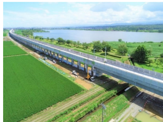
完成後の全景(小松木場湯高架橋工区)
