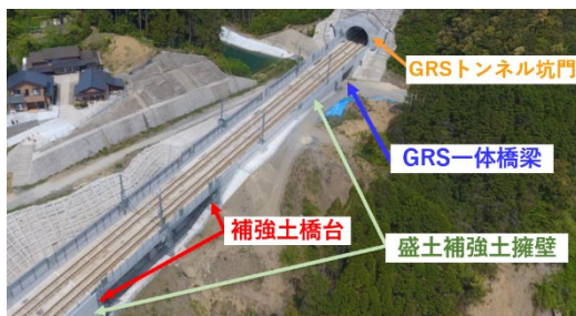
GRS 構造物の積極的な採用 (九州新幹線、大山路高架橋他)
