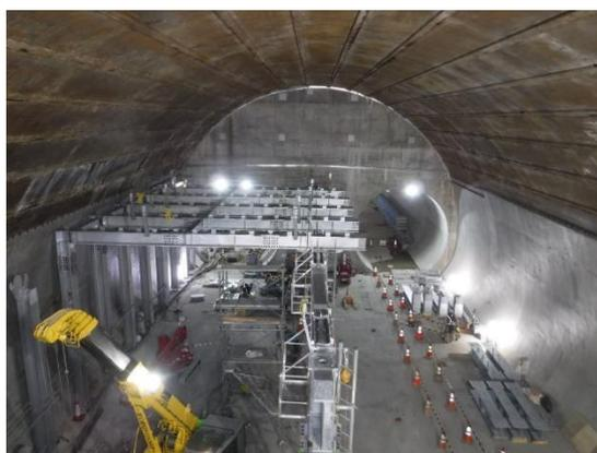
図 3-14 新網島駅大断面トンネル部構築状況
