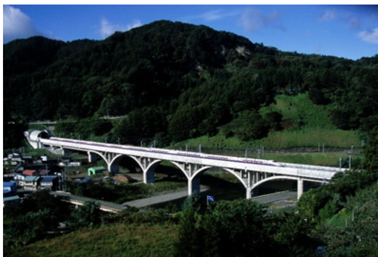
写真－5.18 第 3 馬淵川橋梁
