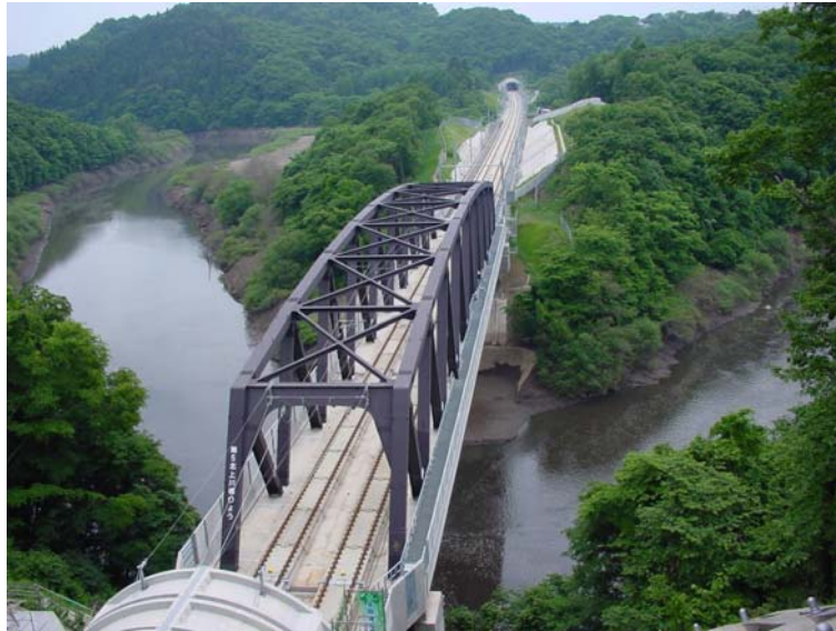
写真－5.19 第5北上川橋梁
