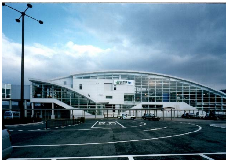
写真－5.23 二戸駅外観
