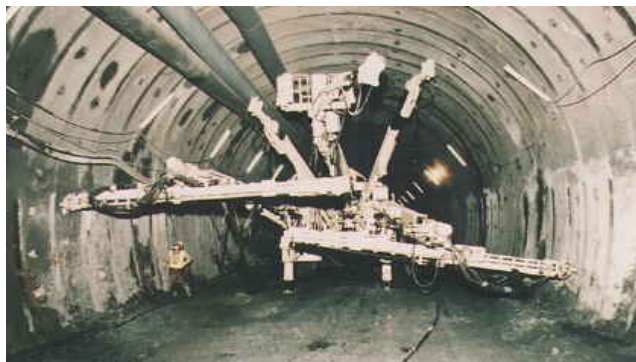
写真－5.21 岩手一戸トンネル(施工中 ゼネラルジャンボ)
