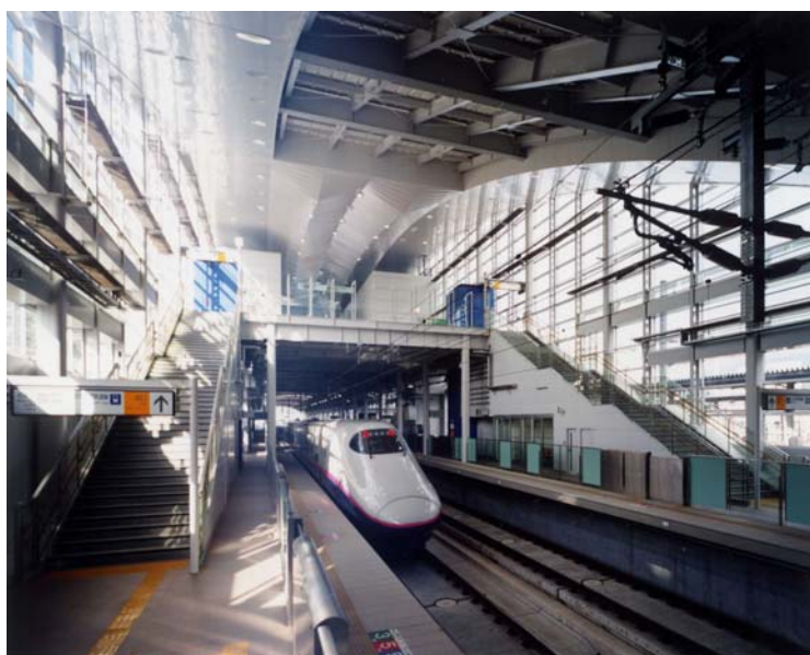
写真－5.24 二戸駅構内
