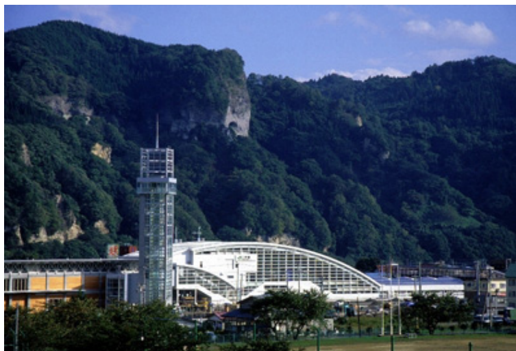
写真－5.20 二戸駅外観
