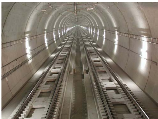
写真－5.22 岩手一戸トンネル(完成後)
