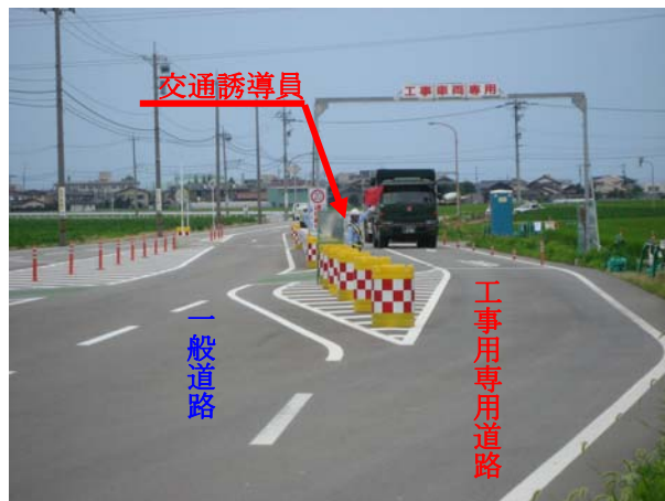
写真－5－D 工事用専用道路
