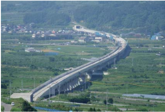
写真-2-A 高丘トンネル～高社山トンネル
