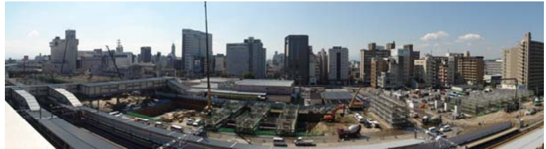
富山駅南口の工事進捗状況(平成23年9月末日)
