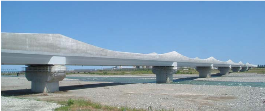
写真－５－Ｂ 姫川橋りょう
