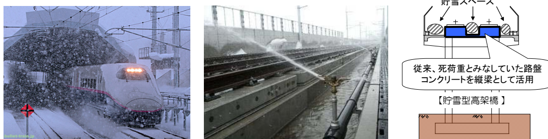
写真—3—B 雪害対策設備の例（東北新幹線）と貯雪型高架橋の概念図
