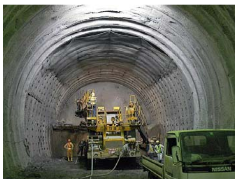
写真—3—A 飯山トンネル
