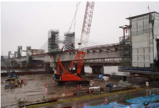
写真-2-C 神通川橋りょう
