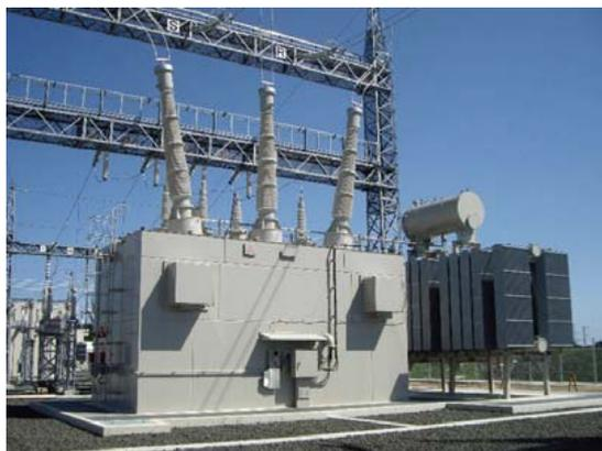
写真-6 東北新幹線 新七戸変電所 ルーフデルタ結線変圧器
