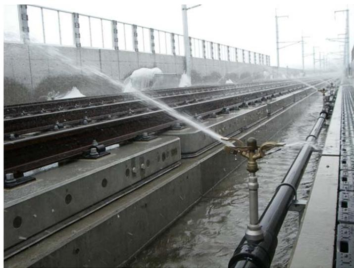
写真 5-30 散水消雪設備
