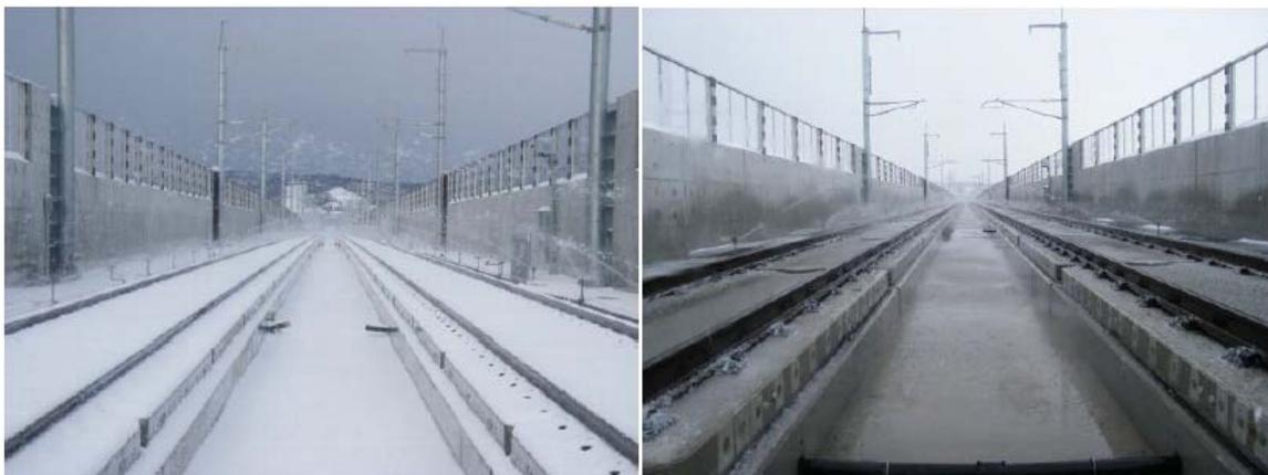
写真 5-31 散水開始（左）と散水 25 分後（右）
