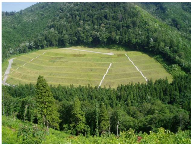
写真 5-22 八甲田トンネルの管理型土捨場
